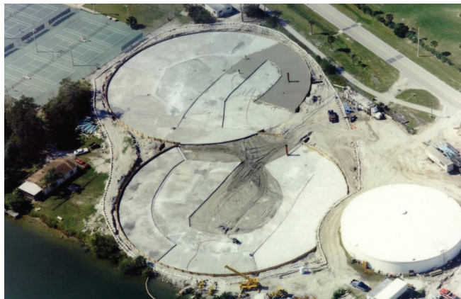
Рисунок 1.8. Фундаментные заливки (Флорида)
