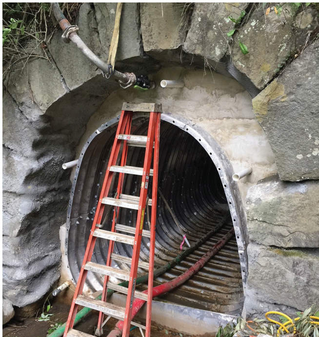
Рисунок 1.6. Заливка затрубного пространства (штат Мэн)
