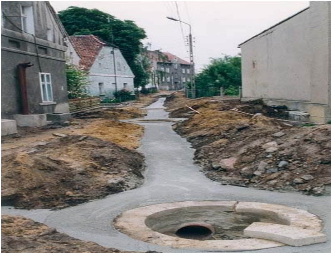
Рис. 6. Прокладання каналізаційної мережі в пінобетоні у м. Глогув, Польща, 1997 р.
