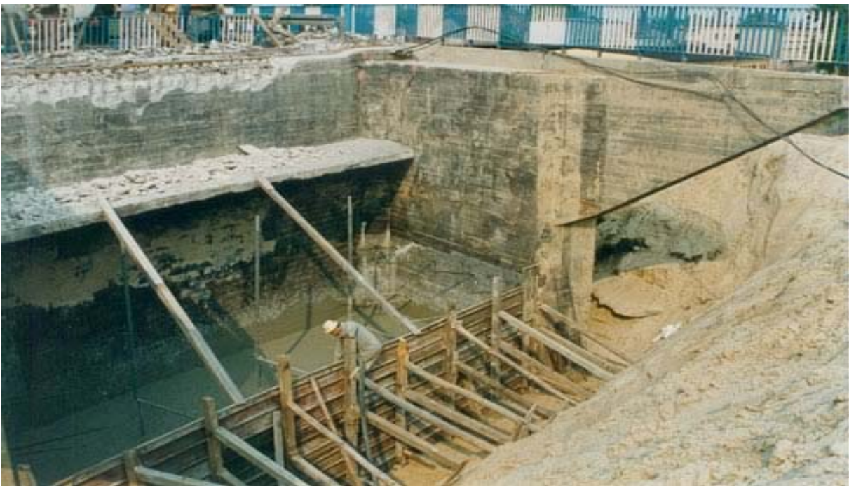
Рис. 5. Заповнення підпори віадуку пінобетоном в м. Вольштинь, Польща
