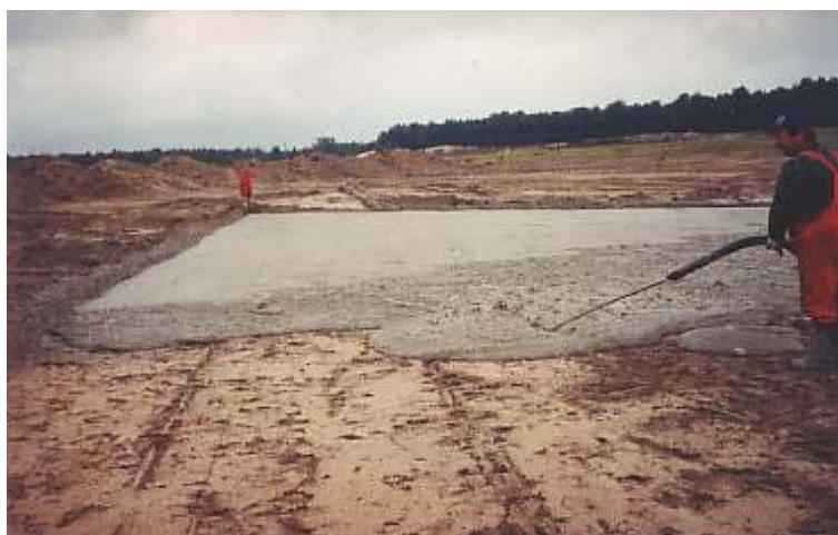
Рис. 1. Виконання основи з пінобетону під паркінг меблевого салону фірми "Вахрол" площею близько 900 м 2 в м. Торунь, Польща, 1992 р.
